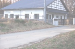
手良浄化センター
