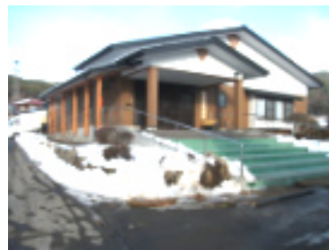
竣工なった野口公民館
