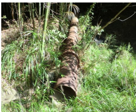
発電所跡地に残された水圧管
