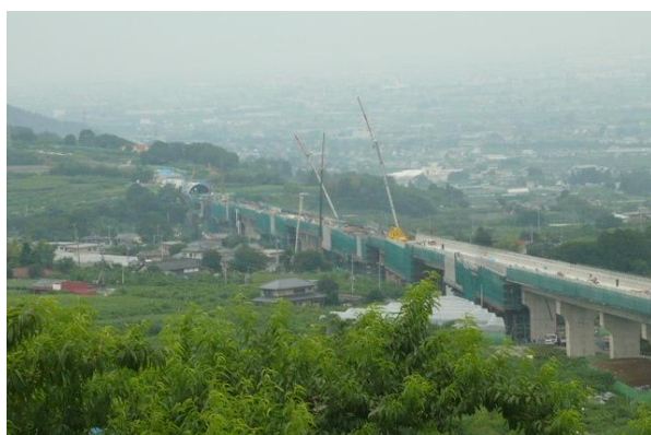
山梨県笛吹市の工事現場
