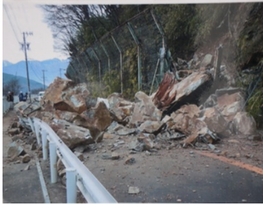
高遠町の国道361号線崩落現場
